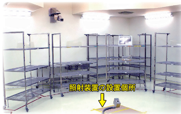
図2 照射室の内部
